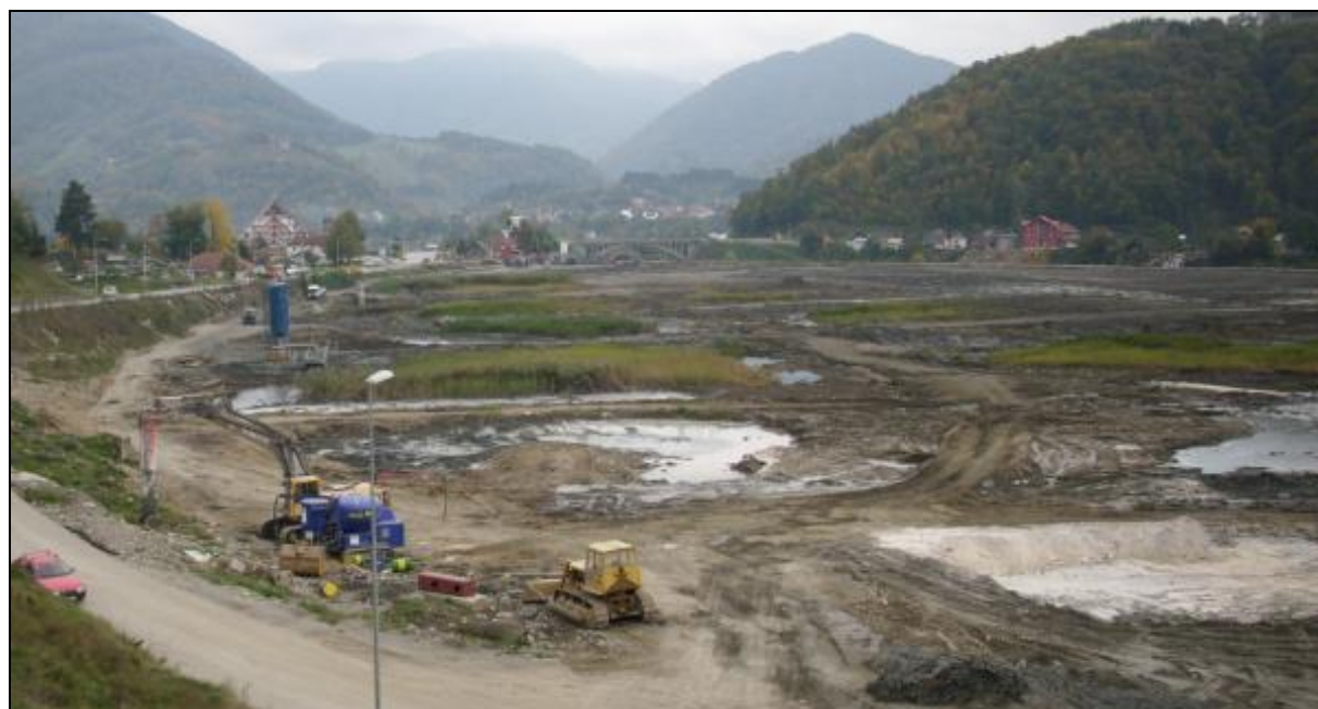
Odkaliště dolu Brzkovo, Mojkovac (MNE) – vstupní stav lokality
